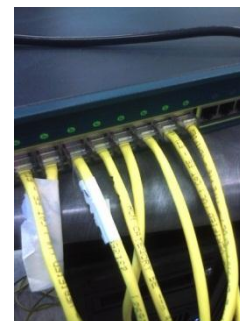
Рис. 4.7 - Подключеие сетевых устройств к концентратору
