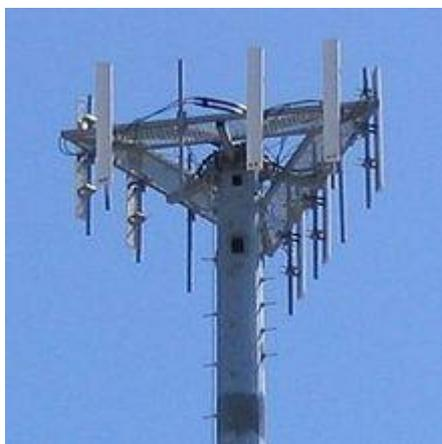
Рис.7.1. Антенны трех базовых станций на мачте
