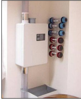
Рис. 7.5. Пневмопочта aerocom (СОМ-станция)
