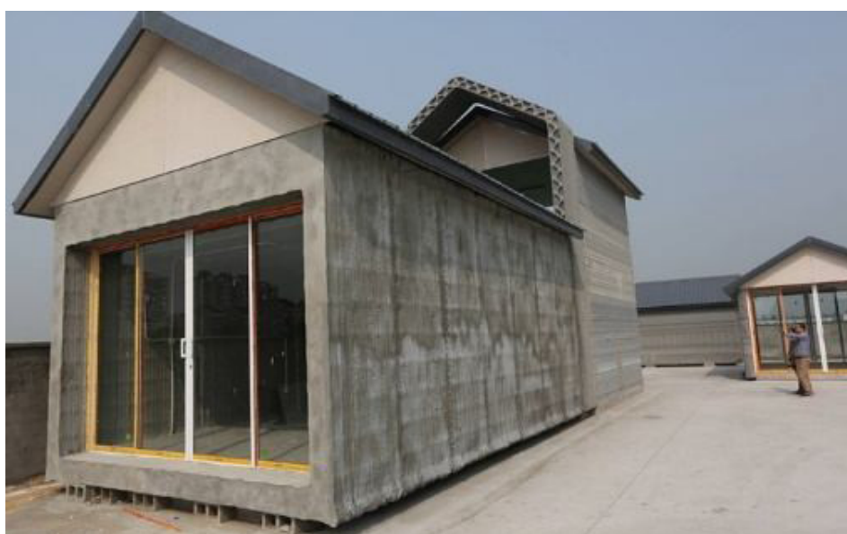
Рис. 5.3. Дома, собранные из напечатанных блоков
