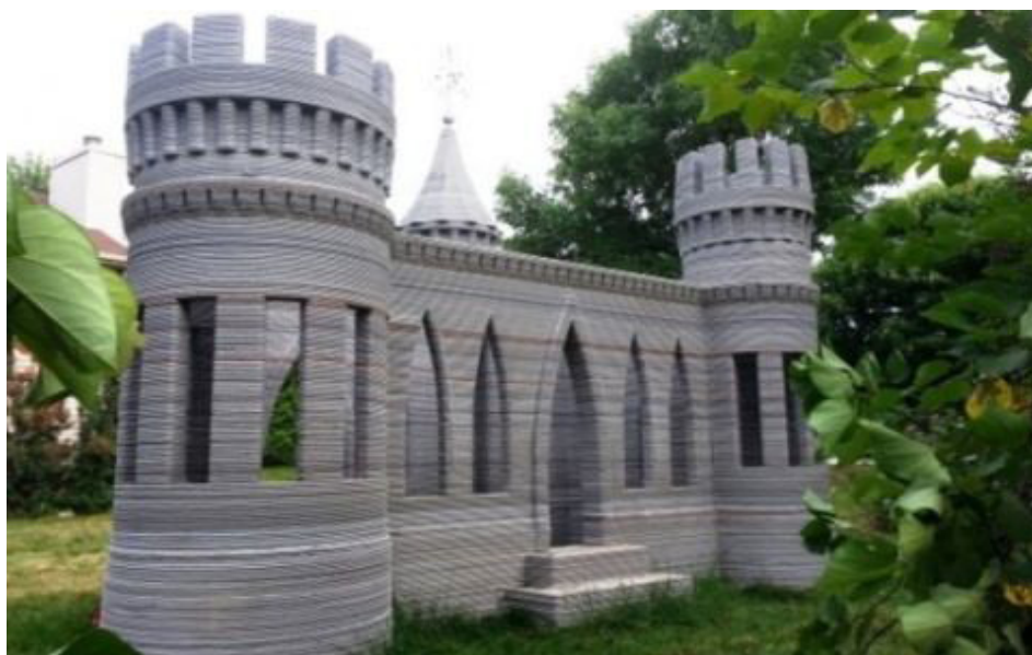
Рис. 5.2. Замок А. Руденко, возведенный с помощью аддитивной технологии
